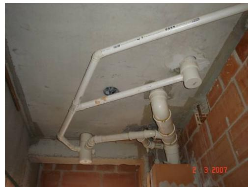
Ilustração 169: Embutimento de instalações hidráulicas no forro. Fonte: Camila Kato
