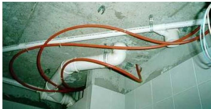
Ilustração 149: Embutimento das instalações hidráulicas no forro. Fonte: [70]
