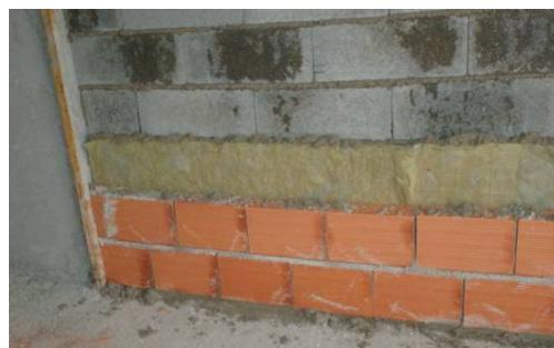
Ilustração 139: Isolamento flexível utilizado na parede de divisa entre duas habitações. Fonte: Camila Kato
