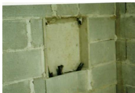
Ilustração 145: Utilização de pré-moldado na caixa de luz. Fonte: [77]
