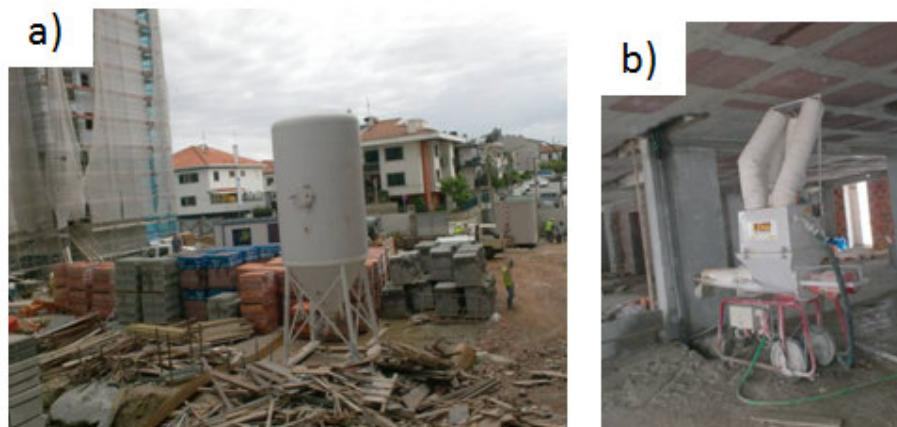
Ilustração 174: a) Silo com argamassa pré-dosada, b) equipamento de mistura. Fonte: Camila Kato
