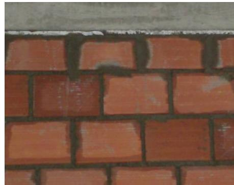
Ilustração 126: Fixação da alvenaria com poliestireno expandido
