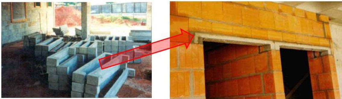
Ilustração 125: Vergas pré-moldadas de concreto. Fonte: [72]
