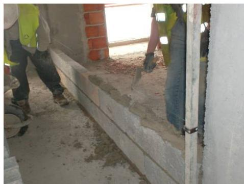
Ilustração 176: Elevação da alvenaria com utilização de fio de pedreiro e prumo. Fonte: Camila Kato
