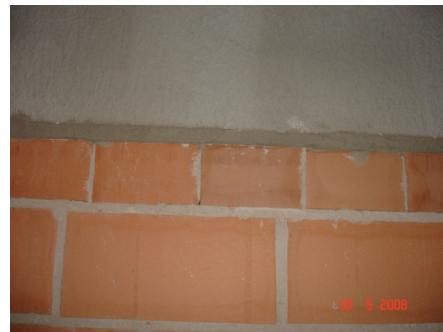
Ilustração 165: Fixação com argamassa à esquerda (Fonte: Chaves e Diego Gazolli).
