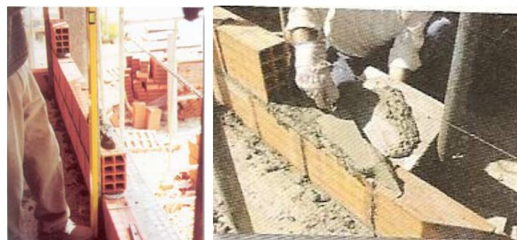
Ilustração 133: Elevação da parede. Fonte: [10]
