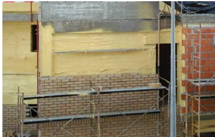
Ilustração 137: Parede dupla com tijolo à vista executada pelo exterior e isolamento térmico de poliuretano projetado. Fonte: [www.pombalinjecta.com](http://www.pombalinjecta.com) acesso no dia 09/ 02/ 2009.
