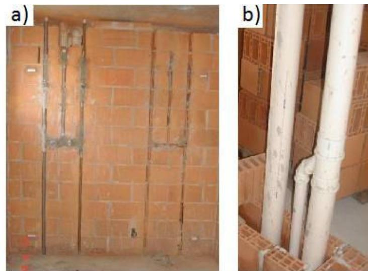
Ilustração 168: a) Cortes da alvenaria para instalações hidráulicas. b) Execução de shaft. (Fonte: Chaves e Diego Gazolli)
