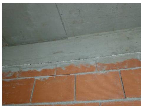
Ilustração 177: Ligação da alvenaria com a viga através de poliestireno expandido. Fonte: Camila Kato
