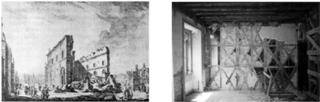
Ilustração 13: Destrução no terremoto de 1755, e a gaiola Pombalina (à direita). Fonte: [8]
