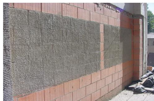
Ilustração 82: Painéis de revestimento. Fonte: [49]
