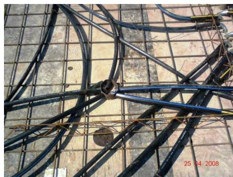
Ilustração 166: Posicionamento dos eletrodutos na forma da laje. Fonte: Diego Souza, Guilherme Corsini e Juliana Ortona
