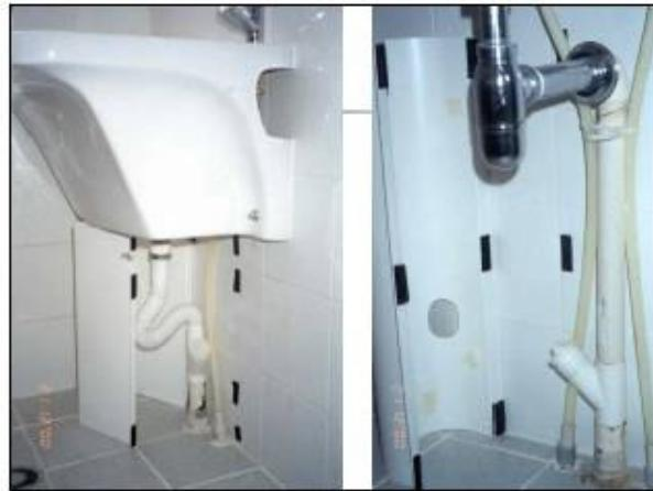
Ilustração 151: Exemplo de uso de carenagem em tubulações hidráulicas. Fonte: [70]
