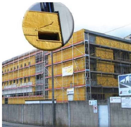
Ilustração 140: Isolamento de poliuretano projetado. Fonte: [www.pombalinjecta.com](http://www.pombalinjecta.com) acesso no dia 09/02/2009.
