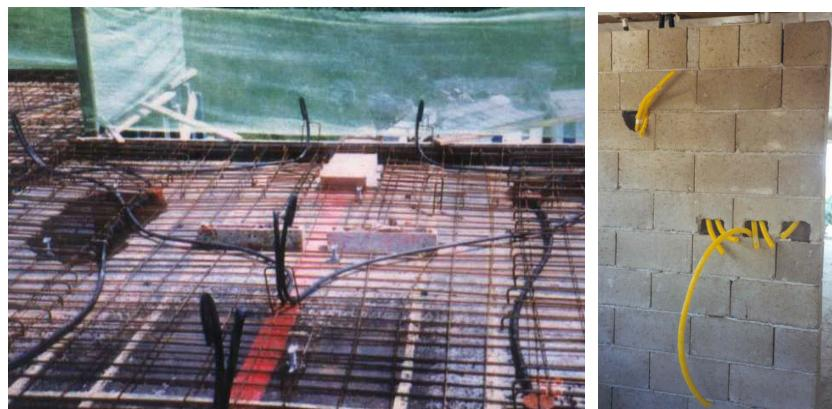
Ilustração 142: Embutimento dos eletrodutos na laje e sua passagem nos furos dos blocos. Fonte: [77]
