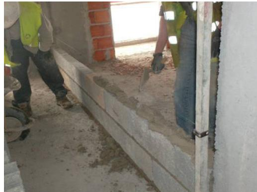
Ilustração 122: Elevação de parede em Portugal com uso de colher de pedreiro. Fonte: Camila Kato
