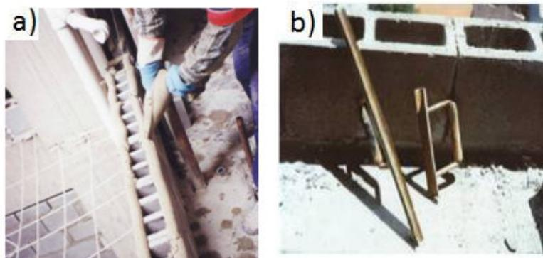
Ilustração 121: a) Cordões de argamassa feitos com bisnaga. b) Palhetas. (Fonte: [72])
