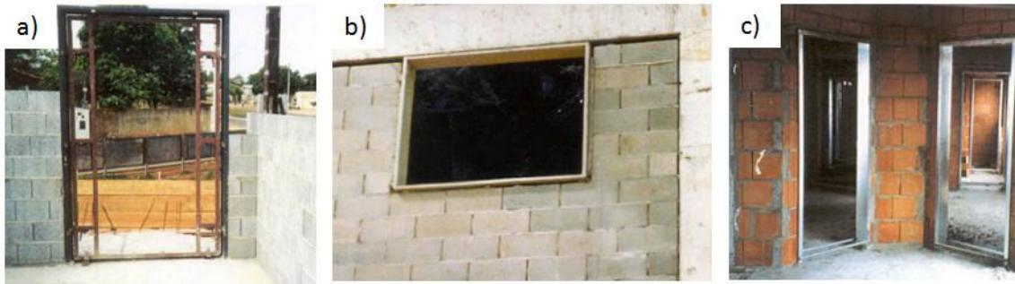
Ilustração 124: Elementos que definem vãos de esquadrias - a) Gabarito metálico; b) Contramarco . C) Batentes envolventes.
