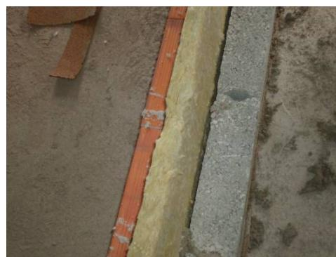
Ilustração 173: Parede dupla com isolamento de lã de rocha. Fonte: Camila Kato
